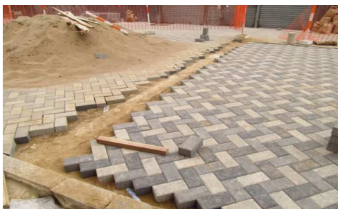
Proceso de asentado de adoquines
